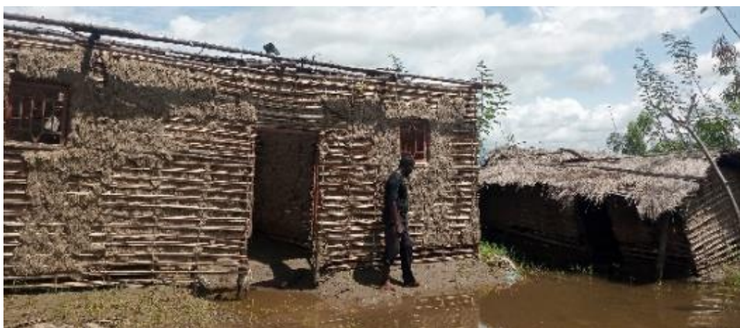
Photo 2 : Types d'habitations à démolir ( dans l'emprise du PF)
