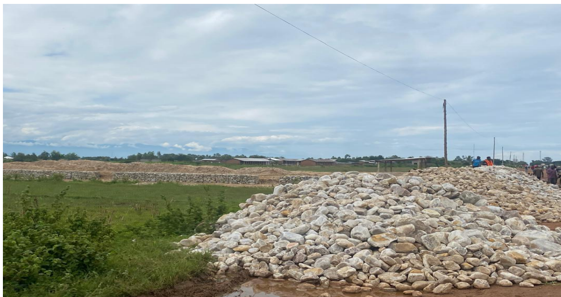
Photo 11 : Route d'accès du site de l'entrepôt du MAGEBU en cours de construction à Gatumba
